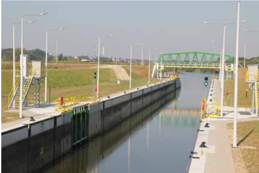
Modernisation des ouvrages sur l'Oder
